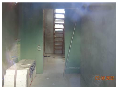
Skats uz sanmezglu un priekštelpu Ēkas 1.stāvā
